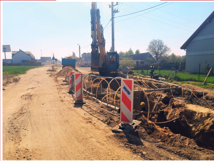
Budowa sieci wodociągowej w miejscowościach Pierzchno i Runowo
