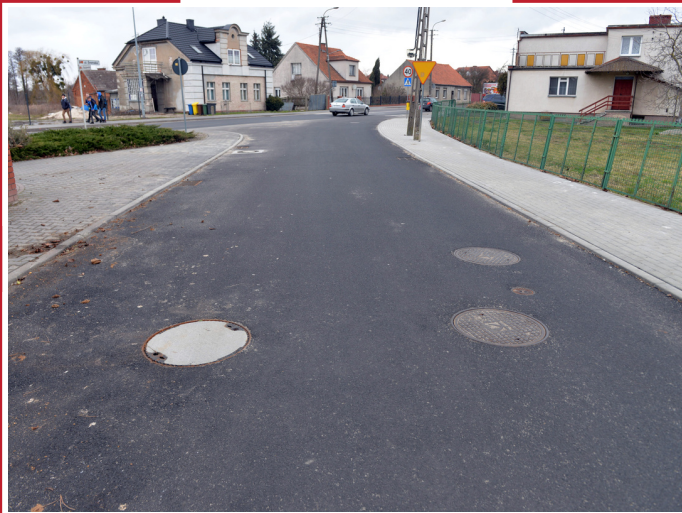
Kanalizacja deszczowa ul. Błażejewskiej w Kórniku (Bninie)
