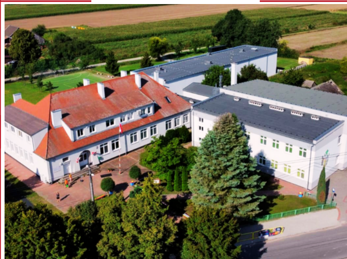
Szkoła Podstawowa w Radziewie po rozbudowie i termomodernizacji
