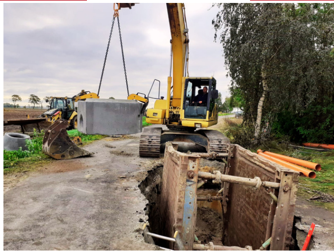
Budowa sieci wodociągowej Pierchno-Runowo-Szczodrzykowo
