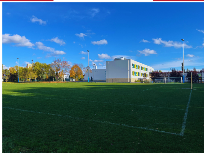
Nowe skrzydło Szkoły Podstawowej w Robakowie i oświetlenie boiska
