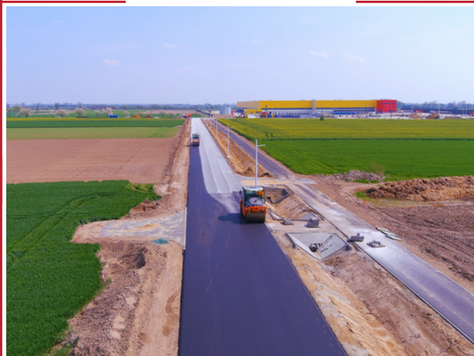
Budowa ul. Stachowskiej w Robakowie – etap II
