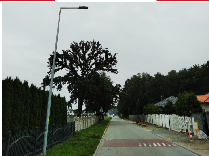
Oświetlenie na ul. Osiedle Przylesie
