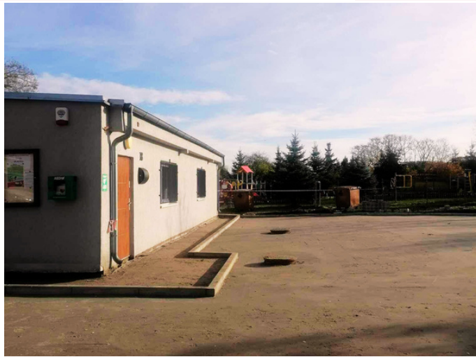
Parking przy świetlicy wiejskiej
