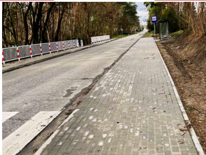
Chodnik przy ul. Głównej
