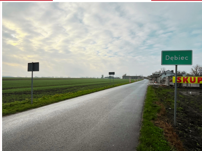
Droga gminna po przebudowie
