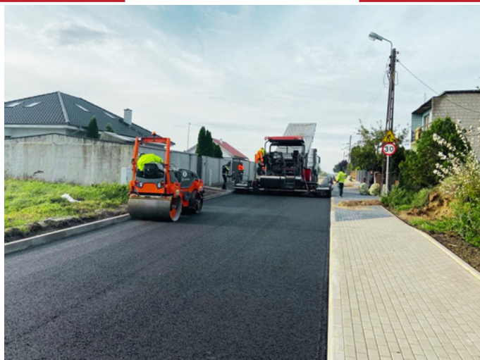
Budowa drogi gminnej w m. Kromolice
