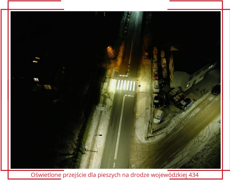
Oświetlone przejście dla pieszych na drodze wojewódzkiej 434
