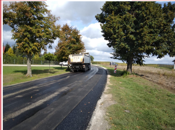
Budowa drogi powiatowej Biernatki-Prusinowo (zdjęcie w trakcie prac)
